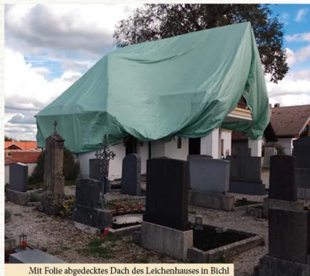
Mit Folie abgedecktes Dach des Leichenhauses in Bichl
