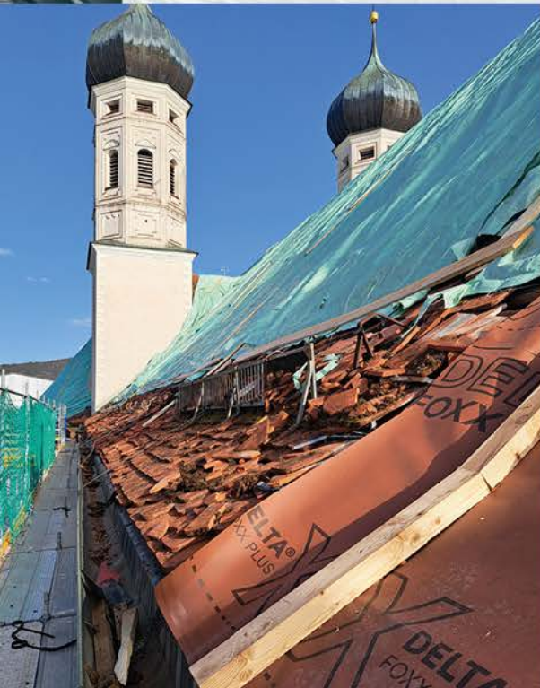
Beginn der Dacharbeiten im Nordwesten mit Unterdach und Dachbahn im April 2024
