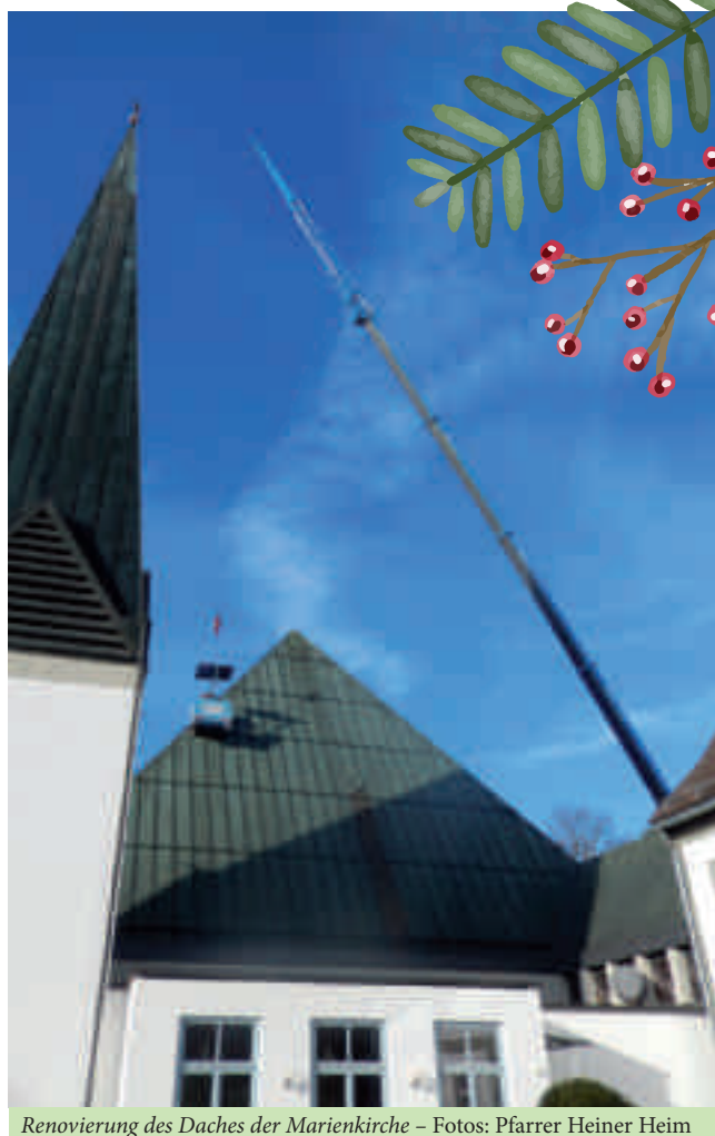
Renovierung des Daches der Marienkirche – Fotos: Pfarrer Heiner Heim
